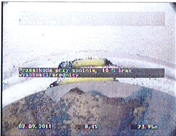
VCR Nr: 1_3A 73,95m, Przeszkoda przy spoinie, 10 % brak wysokości/średnicy
