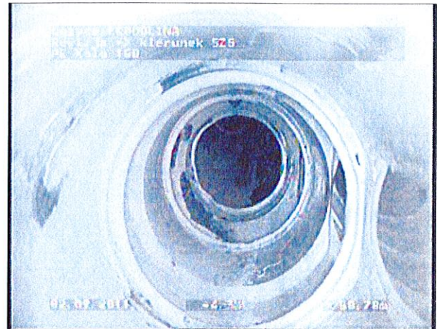
VCR Nr: 1_2B 58,78m, Połączenie, z 12 do 06 godzina, średnica 150 mm, połączenie z SZ4
